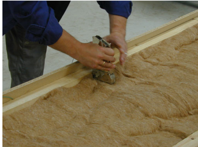
Figur 2 Pladefelt med høruld i pladeform med klammer.
