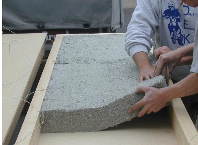
Figur 2 Applicering af celluloseuld i pladeform
