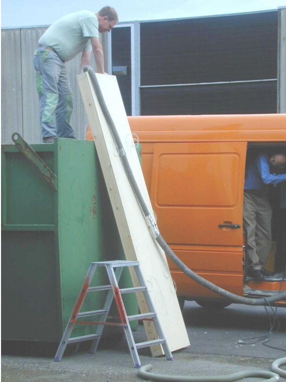
Figur 1 Applicering af celluloseuld som løsulld.
