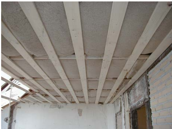
Isolering i tagrum ved hjælp af hørformstykker
